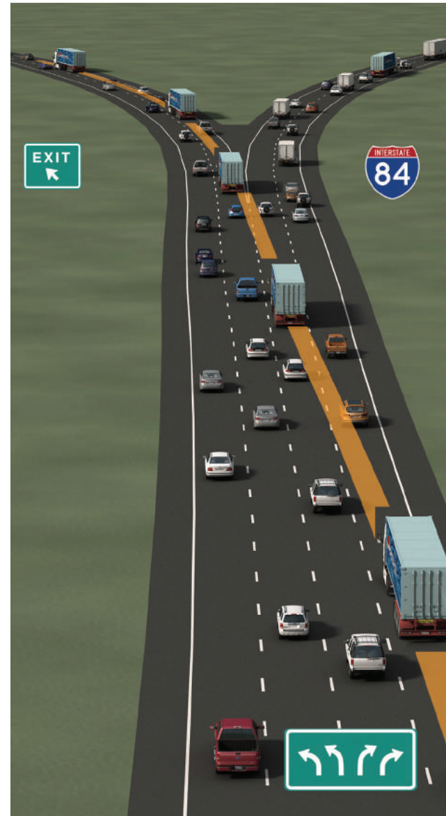
Las rampas a la izquierda significan que el tráfico debe cruzar los carriles para salir
