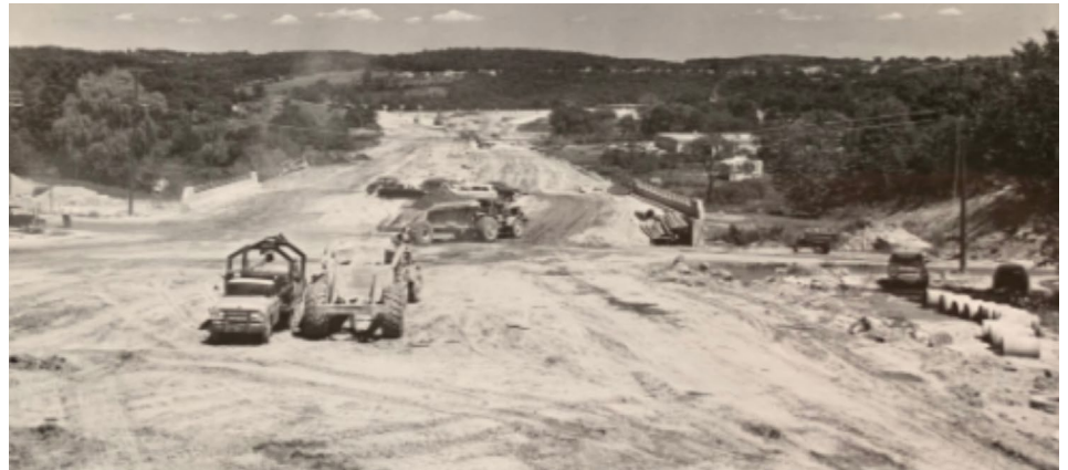
Esta imagem da construção da I-84 na década de 1960 foi fornecida pelo Museu e Sociedade Histórica de Danbury.
